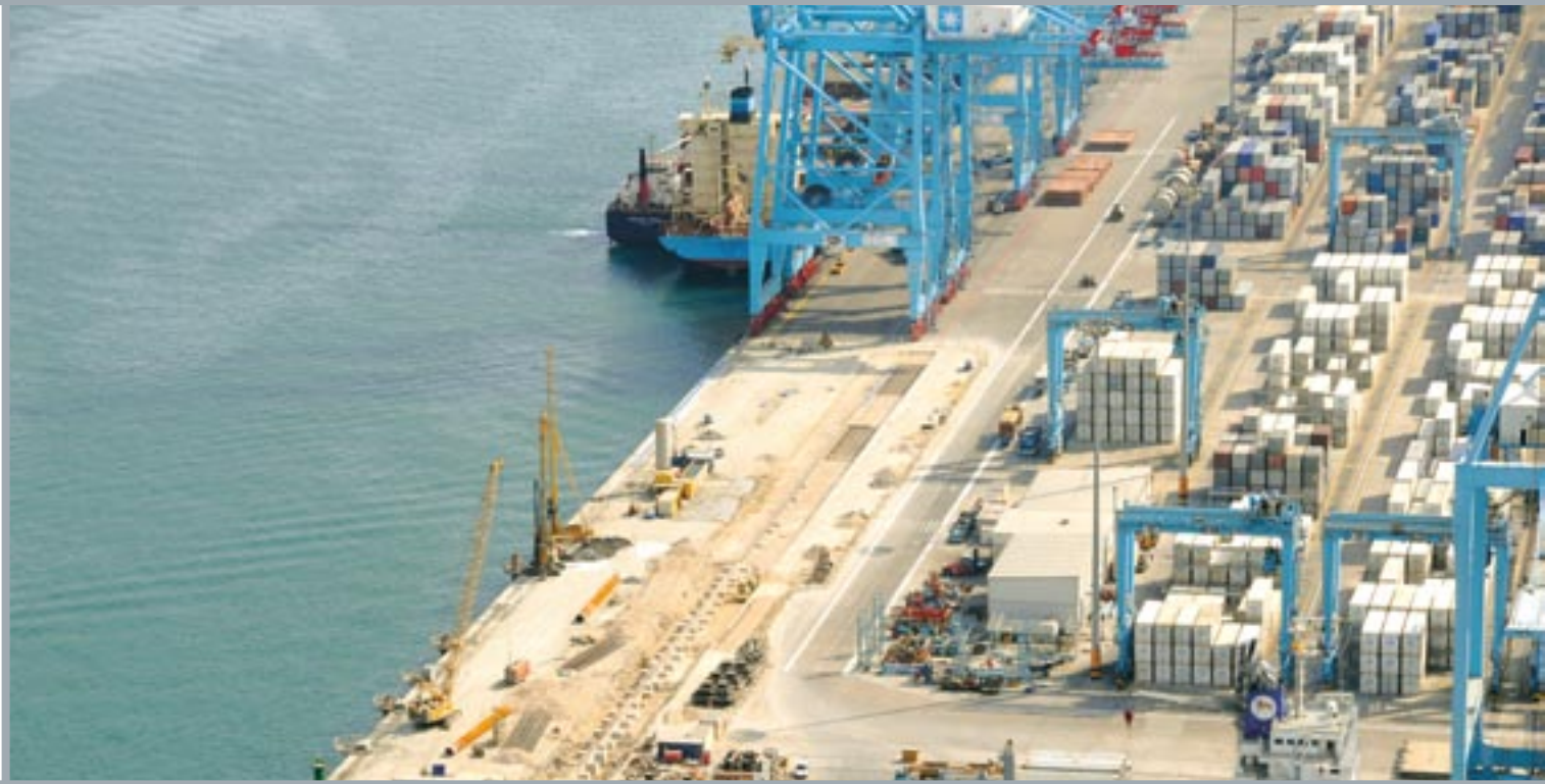
Obras de DETEA en el Puerto de Algeciras.
