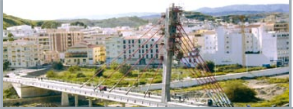
Puente de Albox
