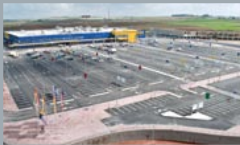
Urbanización de IKEA en Jerez de la Frontera.
