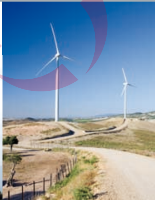
Imágenes de los Parques Eólicos que está construyendo DETEA.
